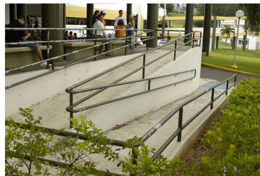
Acceso al primer nivel del edificio de Administración
