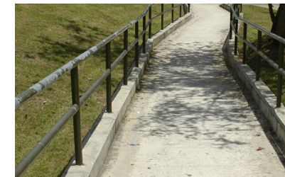
Acceso al edificio de Título V
