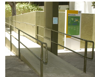
Acceso al segundo nivel del edificio Académico
